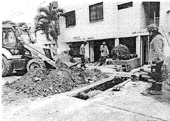
Instalación domiciliar de alcantarillado
