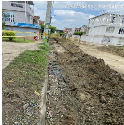
Ilustración 7 Relleno con material de sitio
