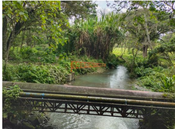
Ilustración 53 Franja forestal Punto de captación Subderivación Nima I
