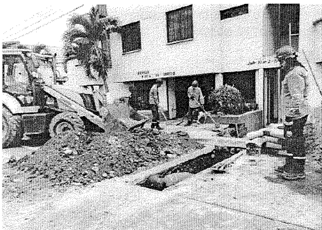
Instalación domiciliar de alcantarillado
