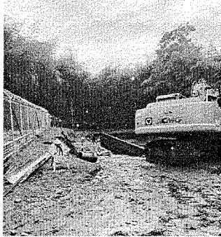
Construcción canal de lavado
